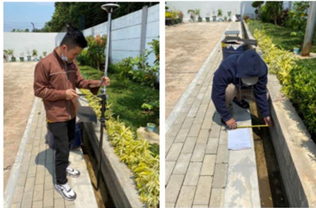
**Gambar 5.** Proses survei dan pengukuran saluran drainase
