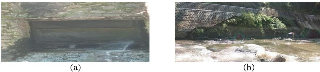
**Gambar 5.** (a) Kebocoran pada pintu air, (b) plasteran terkelupas pada tanggul
