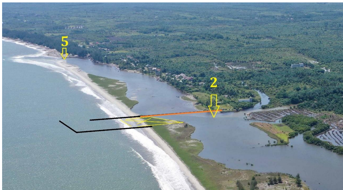
Gambar 6. Bangunan pengarah sungai dan jetty
