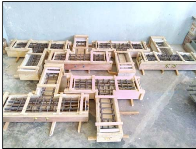
Gambar 3 Cetakan benda uji beserta tulangnya siap untuk dicor
