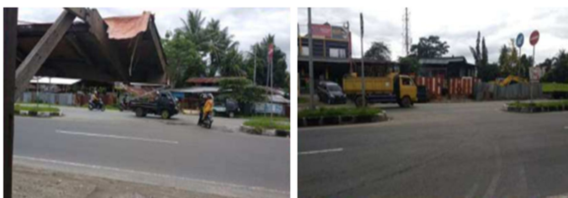
Gambar 7. Bukaan Median Sta 9+171 dan Sta 10+071
