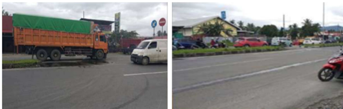
Gambar 6. Bukaan Median Sta 8+041 dan Sta 8+602
