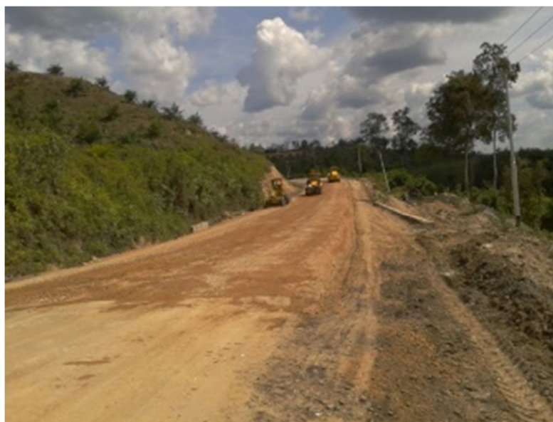
Gambar 2. Perbaikan Terhadap Badan Jalan Yang Turun dan Miring (Tahun. 2011)
