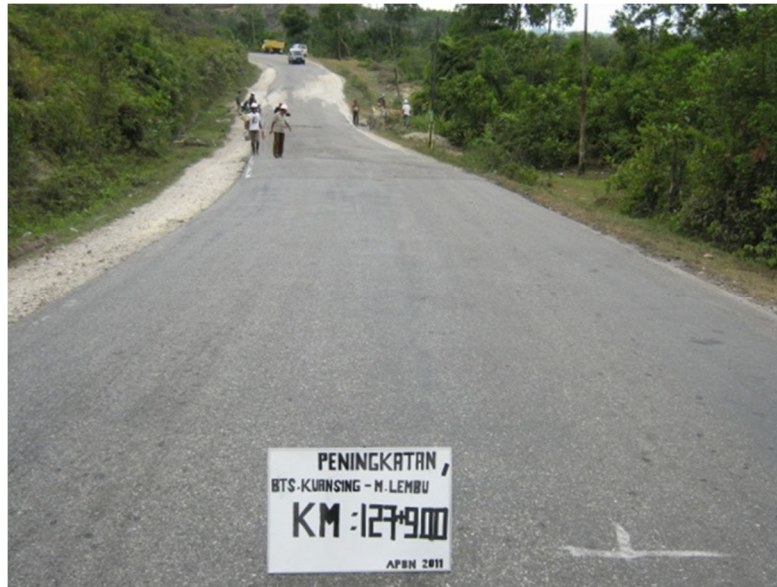
Gambar 1. Kondisi Badan Jalan Turun dan Miring ke Sisi Sungai (Tahun 2011)
