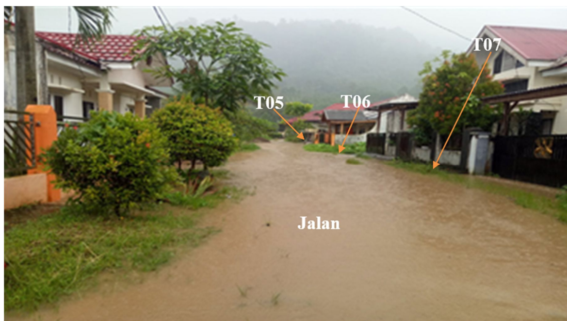
Gambar 6. Banjir pada saluran T05, T06, dan T07 sehingga menggenangi badan jalan pada tanggal 17 Oktober 2019
