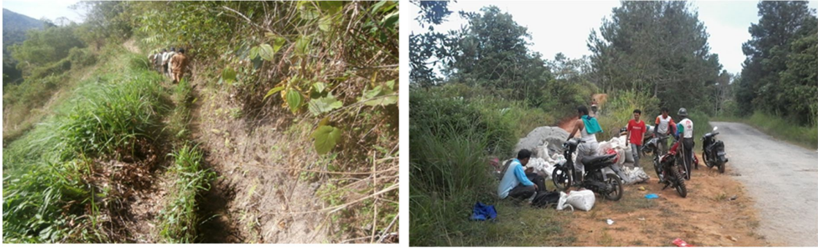
Gambar 1. Lokasi proyek dan mobilisasi material ke lokasi proyek
