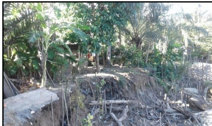
Gambar 1. Kondisi tebing sungai pada bagian tikungan/belokan sungai yang telah tererosi
